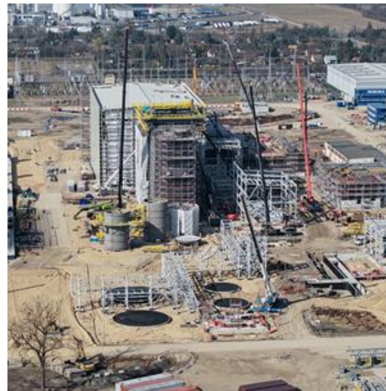
▲ Plac budowy bloku CCGT w Turku
