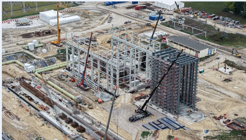
Plac Budowy –widok ogólny
