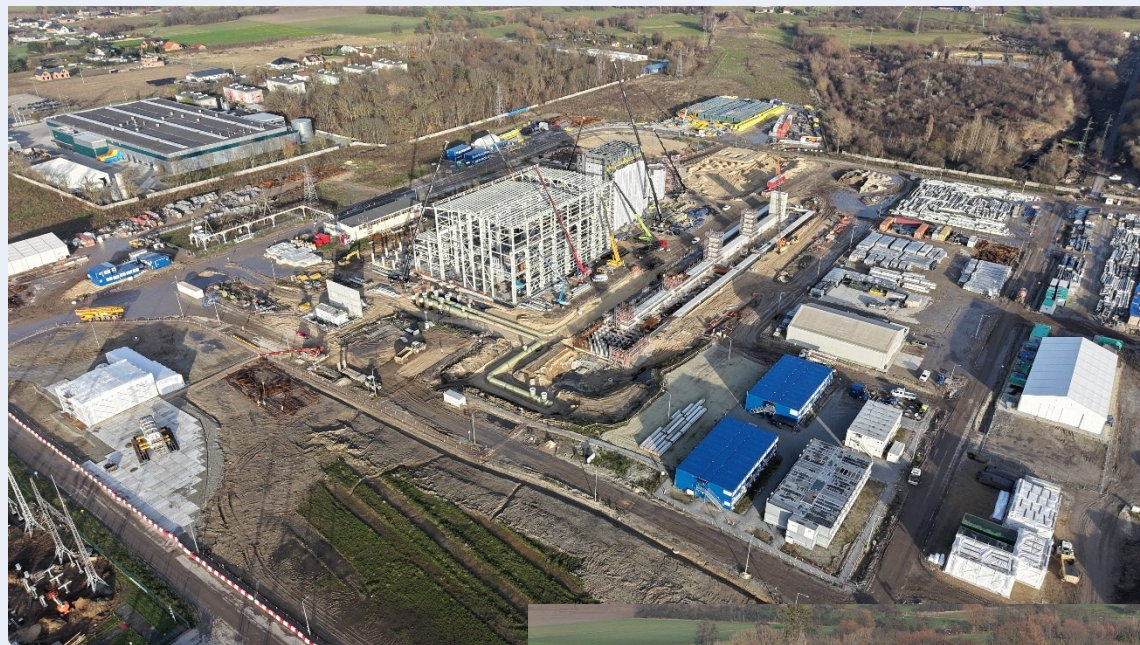
Plac Budowy –widok ogólny
