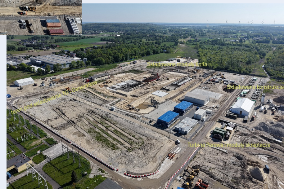
Plac budowy (12 maj 2025) - przyszłej elektrowni CCGT Adamów
