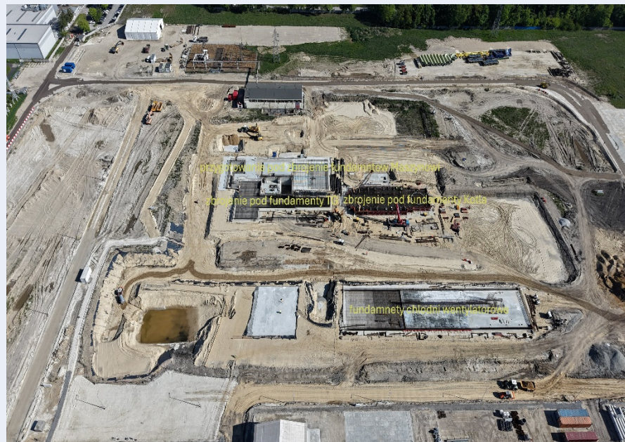
Roboty fundamentowe (przygotowanie do betonowania) głównych budynków bloku CCGT Adamów
