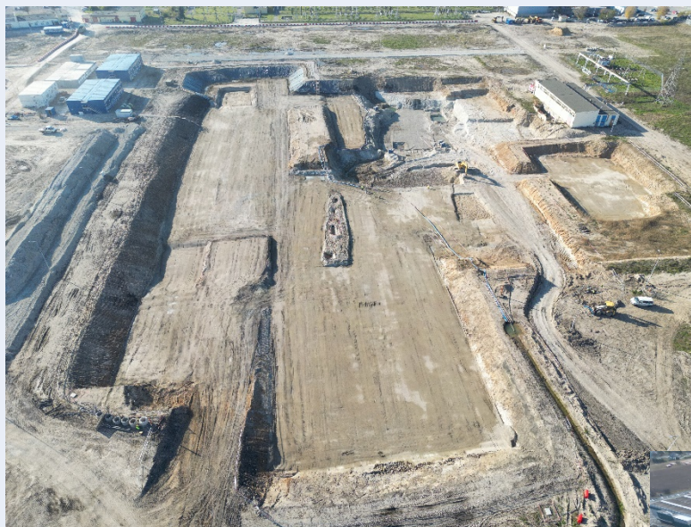
Wykopy pod budynki główne elektrowni
