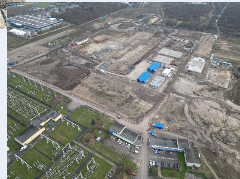
Plac budowy przyszłej elektrowni CCGT Adamów
