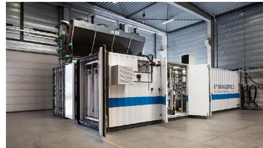
Przykładowy elektrolizer HyLYZER 500-30 bar
