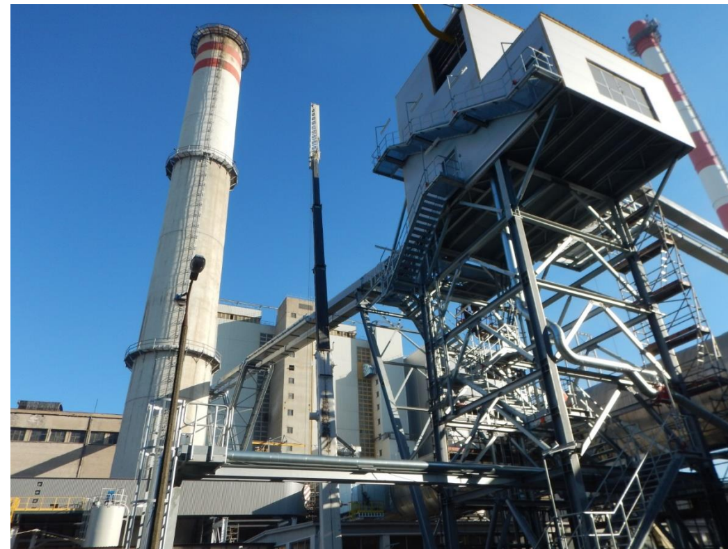
Nowa wieża przesypowa i rurociągi podawania biomasy
